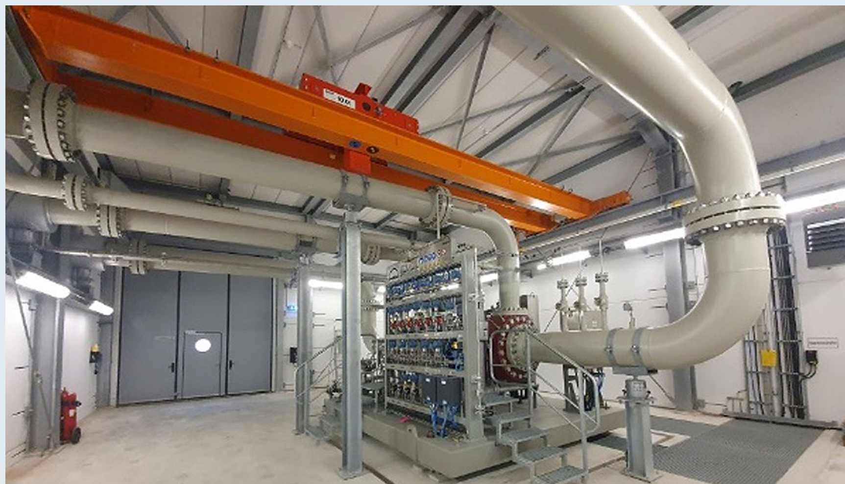
Innenansicht E-Verdichter
