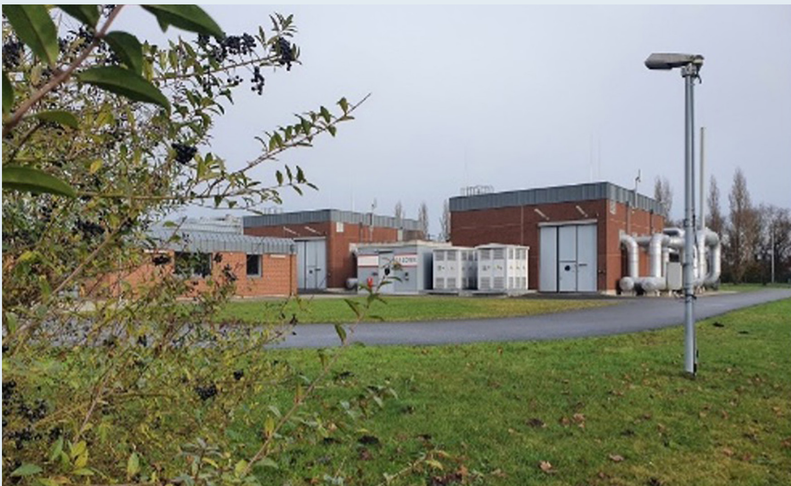
Beispiel Verdichterhallen (Verdichterstation Bunde)
